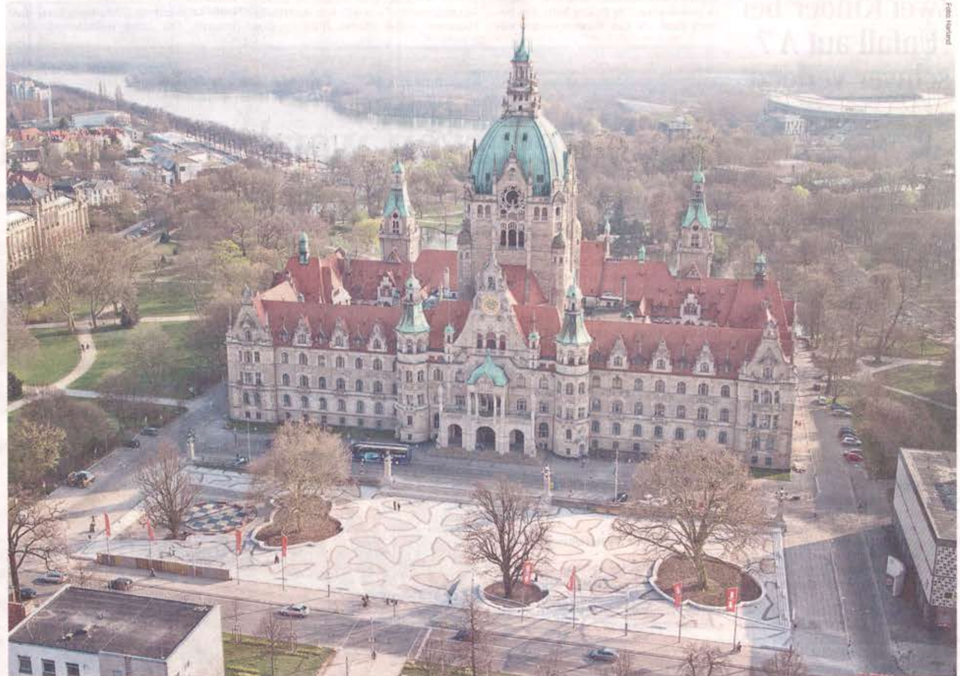
Den Platz schmückt ein Mosaik aus der Feder von Landschaftsarchitekt Kamel Louafi. Das Bodenniveau ist angehoben worden, mehrere Rampen erleichtern Rollstuhlfahrern den Zugang. Der Fußgängertunnel unter dem Friedrichswall ist verschwunden – eine Ampelanlage wurde dafür installiert.
